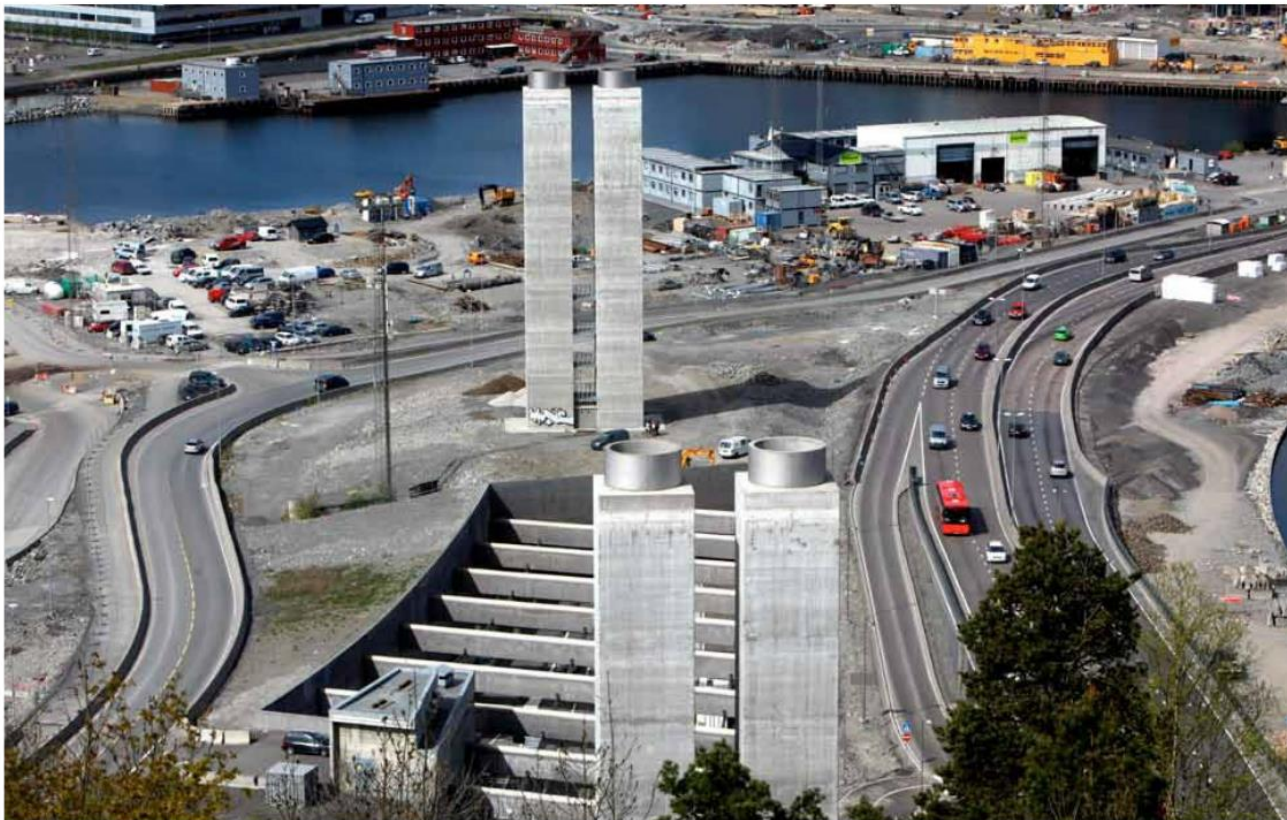
I dag er området mellom ventilasjonstårnene i Bjørvika dominert av pukk, stein, og betong. Neste helg starter byggingen av parsellhagene. FOTO: TRYGVE INDRELIID
